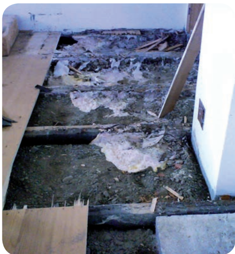
« Démontage des boiseries »
