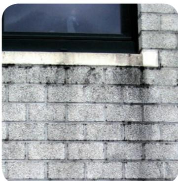
La brique, la pierre, le béton et les crépis minéraux sont des matières poreuses. S'ils ne sont protégés, ces matériaux se trouvent exposés à une série d'éléments qui les altèrent rapidement. Exposées à la pluie et aux vents, les façades absorbent :
