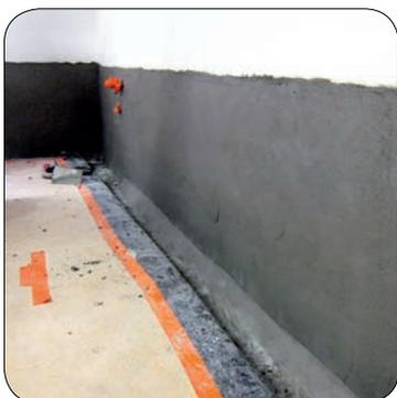
2. La création d'un chanfrein en mortier Hydro+ à la jonction mur/dalle est indispensable pour garantir l'adhérence du cuvelage et protéger la chape de l'humidité.
