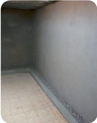
1. Pour ce faire, on maçonne sur la dalle de sol une bordure en béton de 15 ou 20 cm de haut. On aménage une pente en mortier Hydro+ et on enduit complètement la bordure en béton. On place ensuite le drain que l'on recouvre de gravier 7/14. Le cas échéant, passages de portes et jonctions compliquées sont réalisées en plaçant un Acodrain dans le sol.
