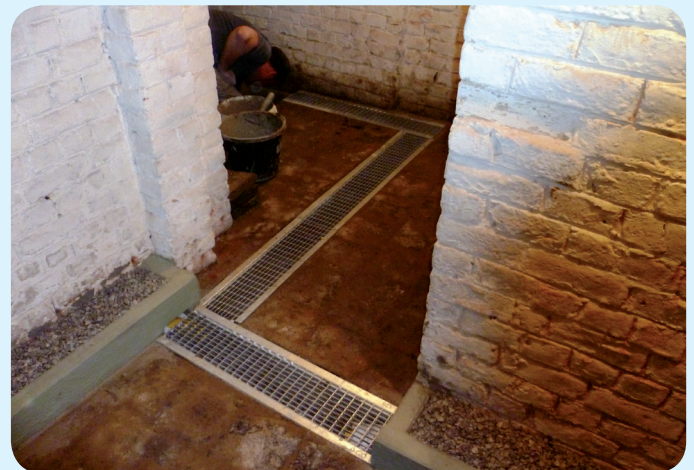
Mortier de scellement pour la pose de rigoles drainantes sur un sol détrempe.
