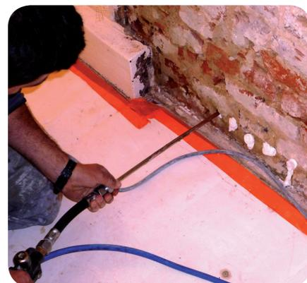
***Le gel silane-siloxane CRD est à la pointe de la technologie en matière de traitement de l'humidité ascensionnelle. Il empêche définitivement la montée capillaire de l'eau dans les murs.***
